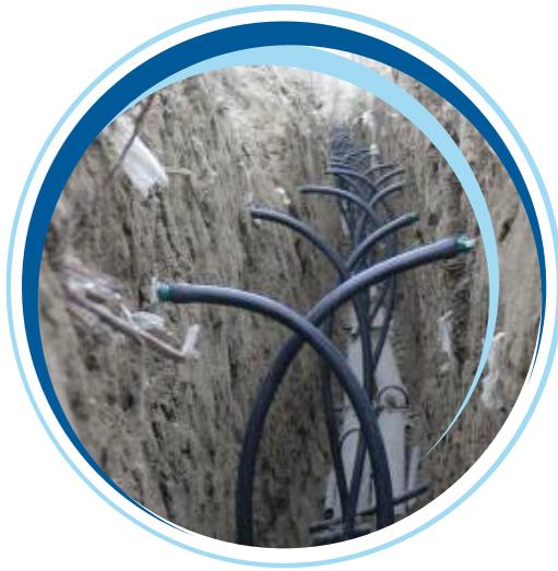
Figura 5: Unión de laterales bajo la superficie con la submatriz de riego
